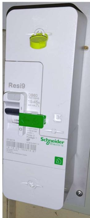
Le tableau de protection est constitué de disjoncteurs, et il y a une protection différentielle, il y a une uniformité des matériels (marques, modèles, lcc,...). Il n'y a pas de repérage ni de schémas.
